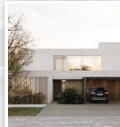
OBRAS CIVILES Y ARQUITECTURA
