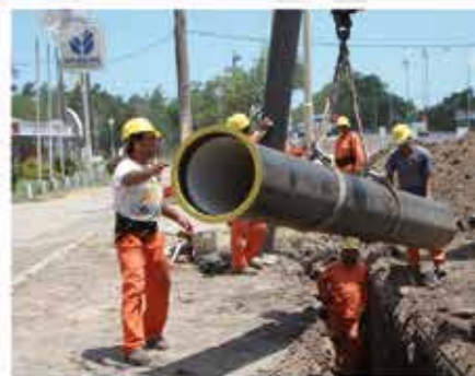
REFUERZO ACUEDUCTO SUR - RECON. AGUAS SANTAFESINAS S.A.
