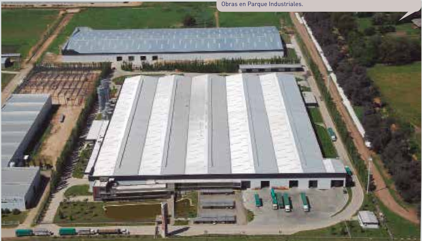
Obras en Parque Industriales.
