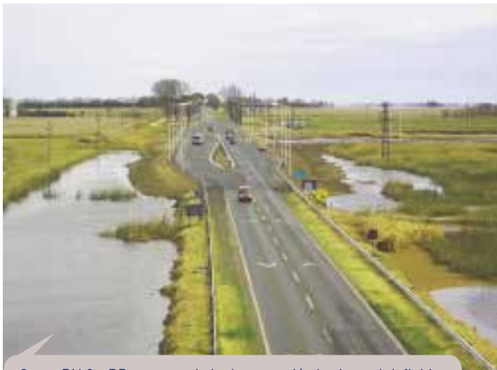
Cruce RN 8 y RP 90 antes de la demarcación horizontal definitiva
